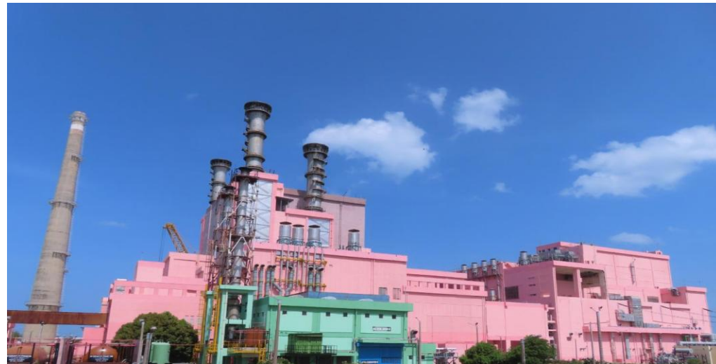
PFBR, 500 MW(e) India, 2026
