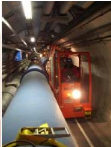
Transport dans le tunnel par véhicule à guidage optique
