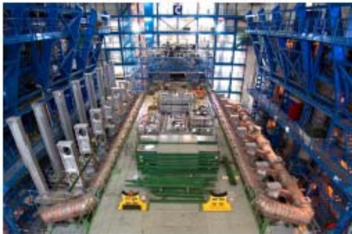
Installation du toroïde d'ATLAS
