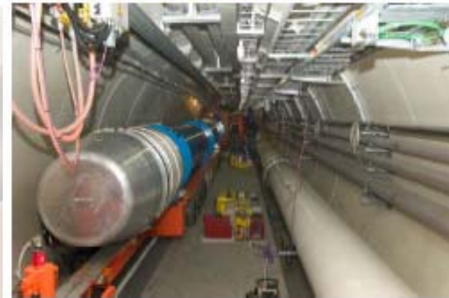
Arrivée sur la position d'installation
